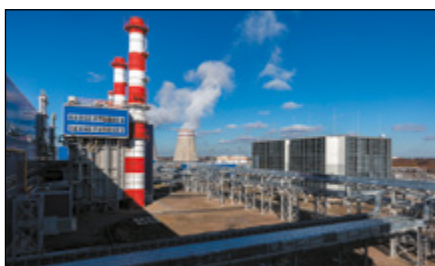
Прегольская ТЭС, Калининградская обл.
